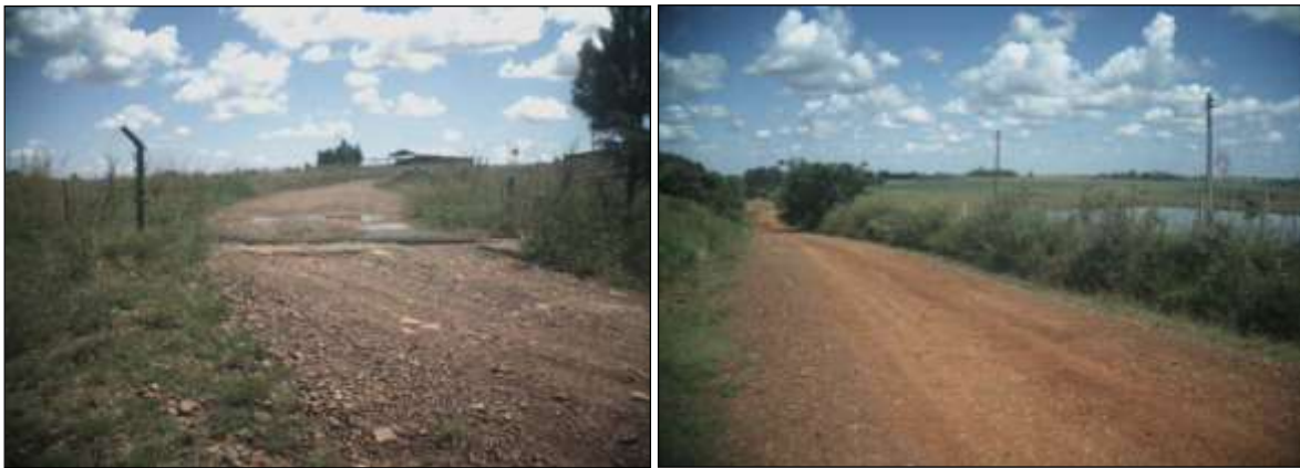
Figura 26: Características das vias de acesso à Unidade de Triagem Fonte: Secretaria Municipal de Planejamento
