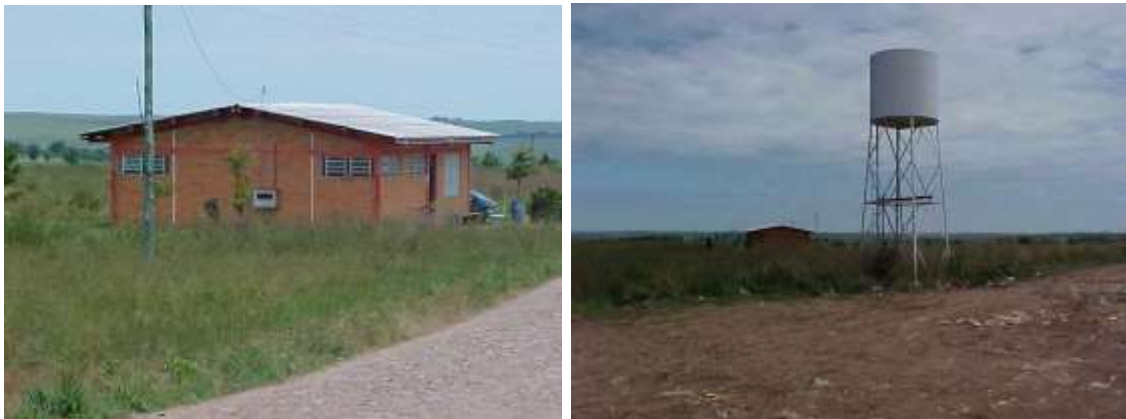
Figura 27: Instalações – refeitório e reservatório de água Fonte: Secretaria Municipal de Planejamento
